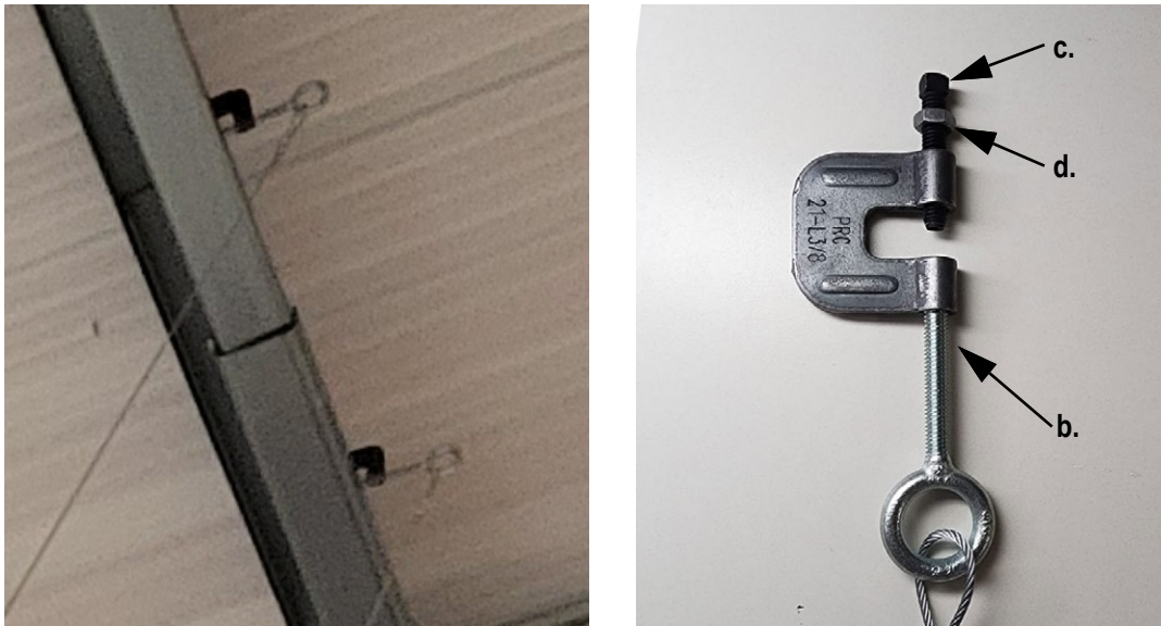
Abbildung 3. Trägerklemme an der Dachkonstruktion
