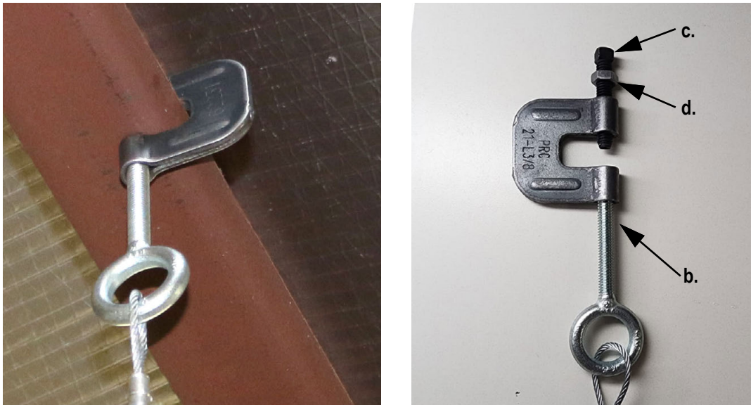
Abbildung 3. Trägerklemme an der Dachkonstruktion
