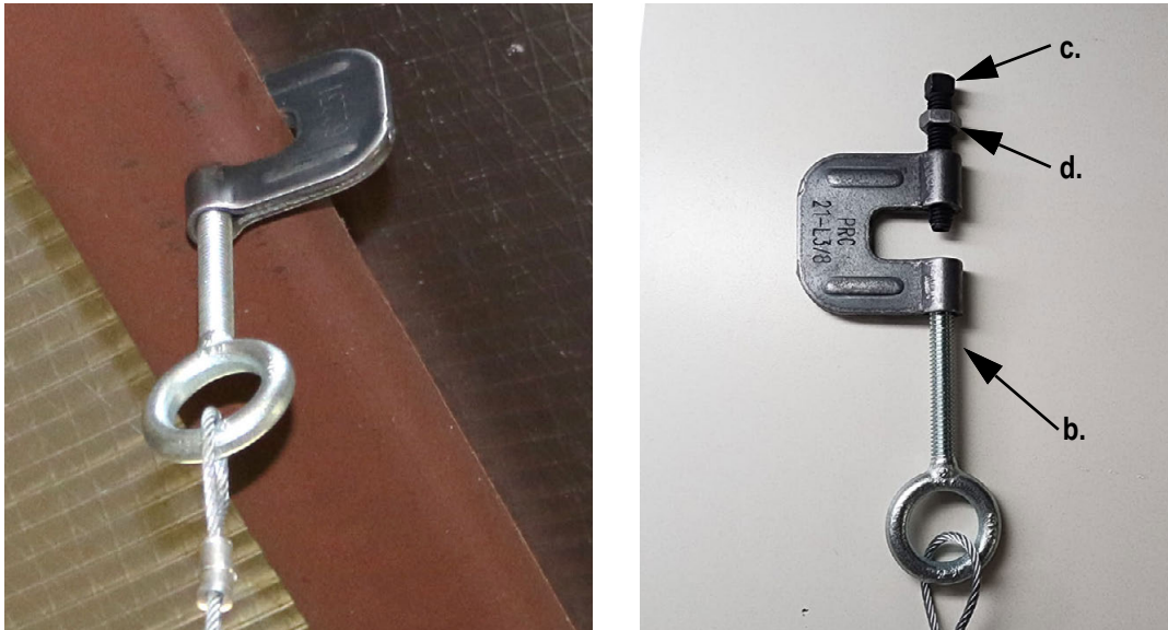
Figura 3. Sujeción de la viga a la estructura del techo
