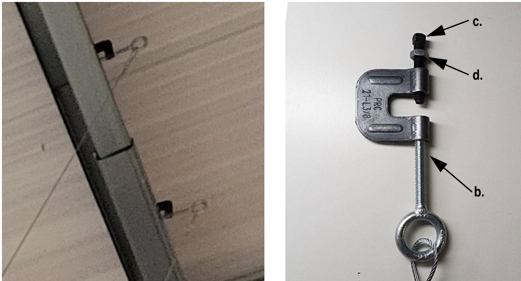
Figura 3. Morsetto della trave per fissaggio alla struttura del tetto
