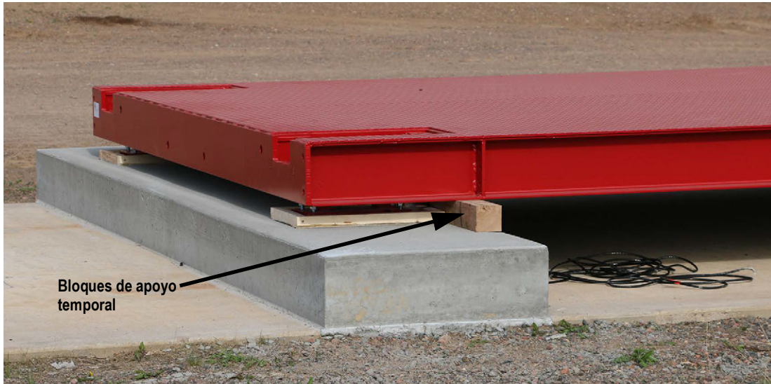
Figura 3-3. Módulo colocado temporalmente sobre bloques de apoyo
