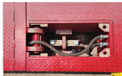
Figura 5-5. Conexión de conduit entre Módulos de Plataforma
