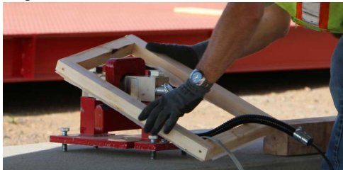
Figura 4-12. Estructura de madera temporal alrededor de la placa base
