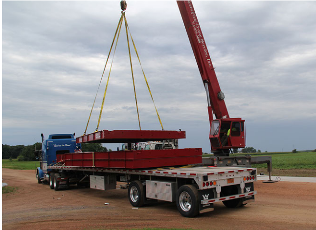
Figura 2-1. Elevación de los módulos de plataforma
