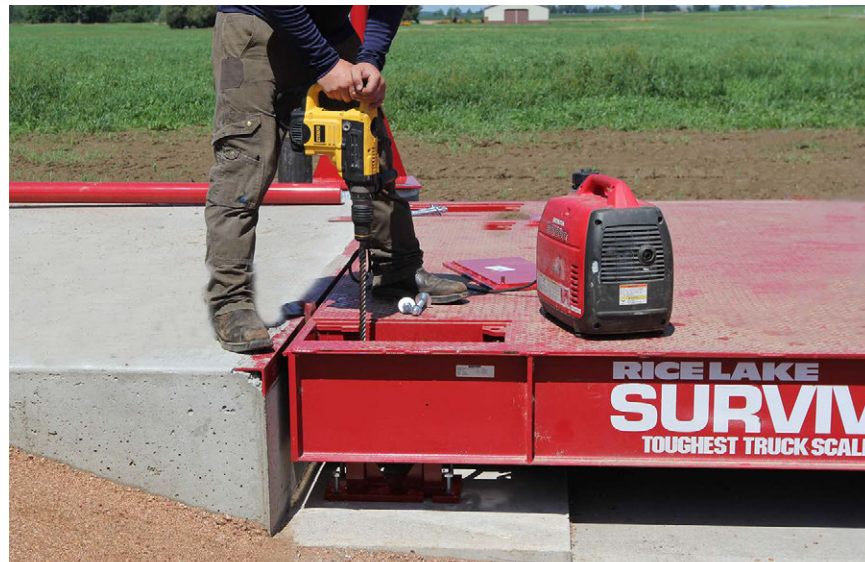
Figura 4-9. Taladre orificios para pernos de anclaje
