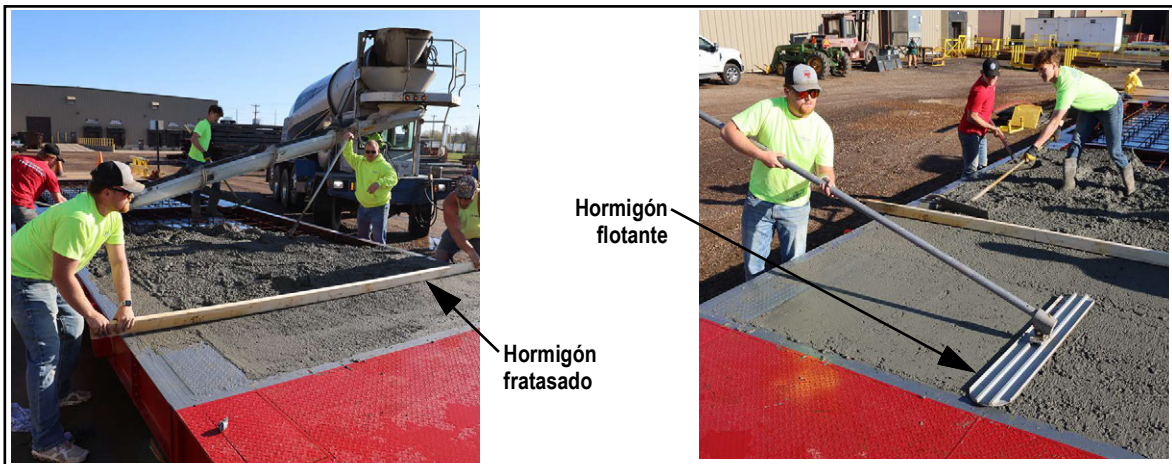
Figura 6-2. Acabado de plataforma de hormigón
