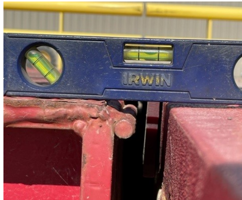
Figura 3-7. Nivelado de la plataforma con los arribos
