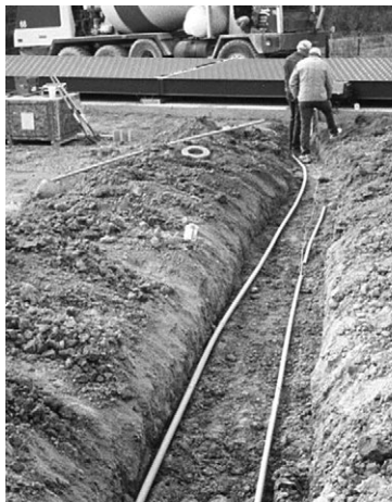
Figura 7-1. Tubo conduit tendido en una canalización
