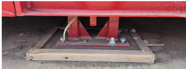
Figura 4-13. Placa base con bastidor y lechada
