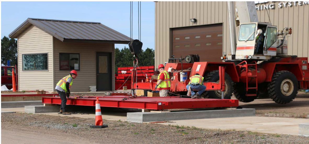
Figura 3-4. Colocación de los módulos en su sitio
