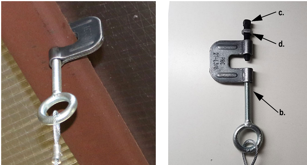
Afbeelding 3. Balkklem aan dakconstructie
