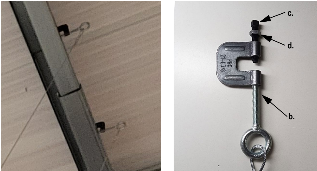
Afbeelding 3. Balkklem aan dakconstructie
