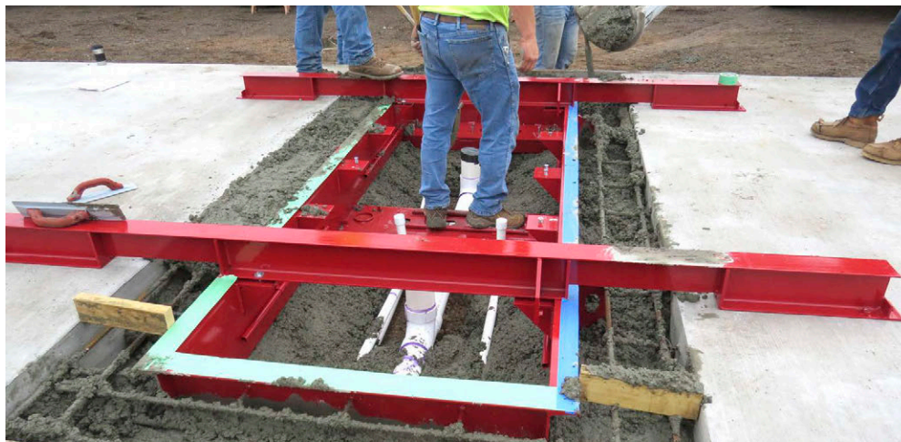
Figure 4-8. Scale Frame Concrete Pour
