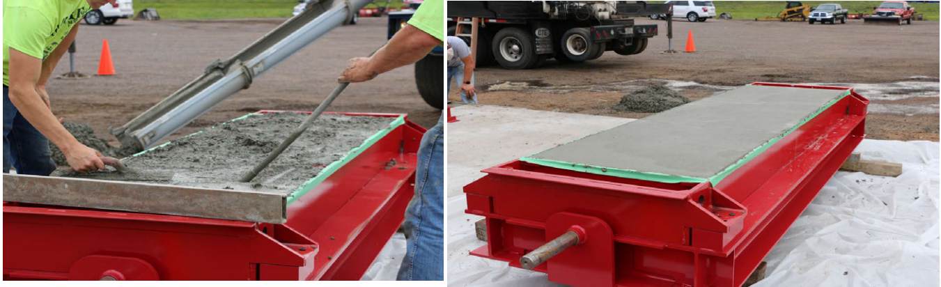
Figure 4-12. Scale Deck Concrete Pour
