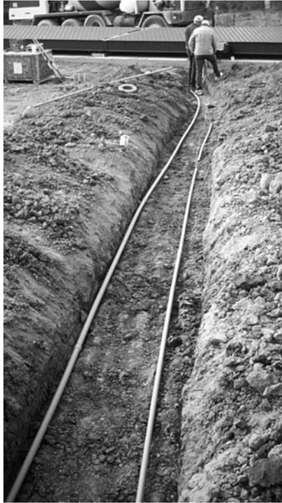
*Figure 3-1. Conduit Run in Trench*
